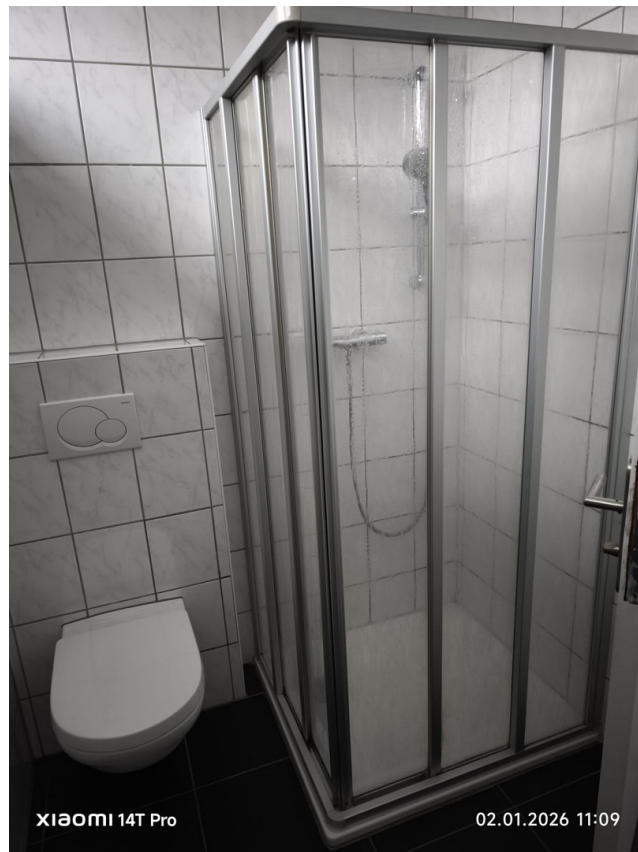
Bad und Dusche II
