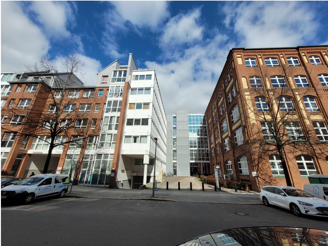
Außenansicht im Winter
