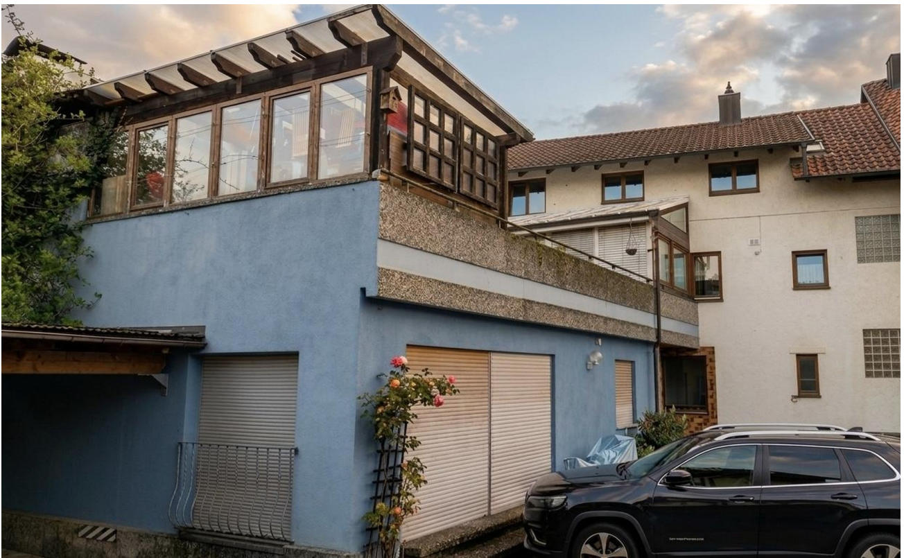
Anbau mit Dachterrasse
