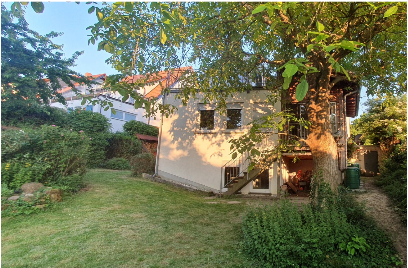
Rückseite Haus / Gartenansicht
