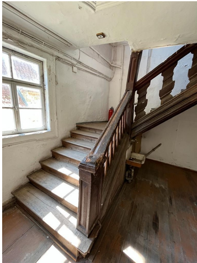
Treppenhaus 1.OG zu 2.OG
