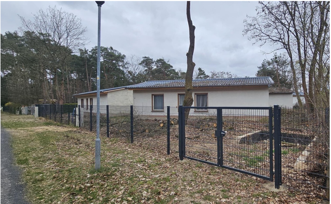
Blick von der Straße
