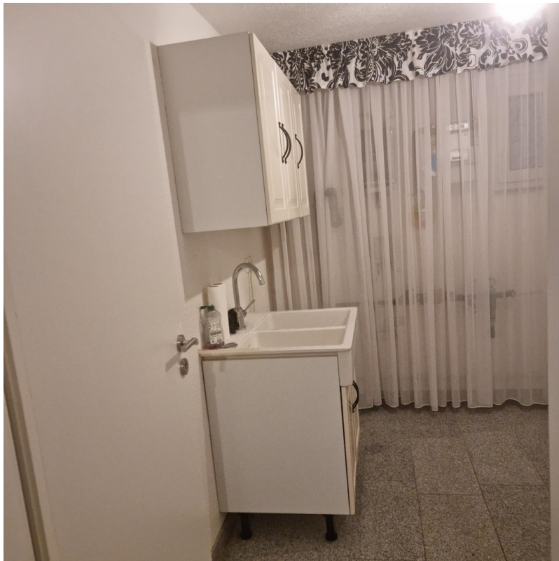
Technikraum im Keller
