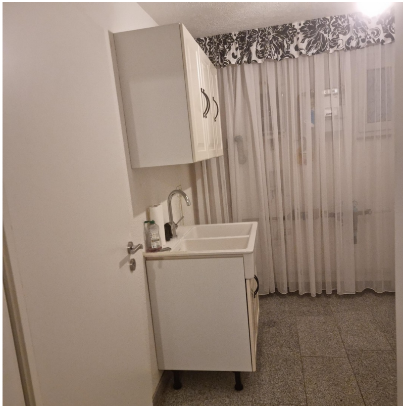
Technikraum im Keller
