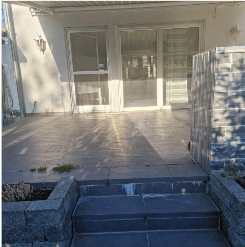
Rückseite Haus + Outdoor-Küche
