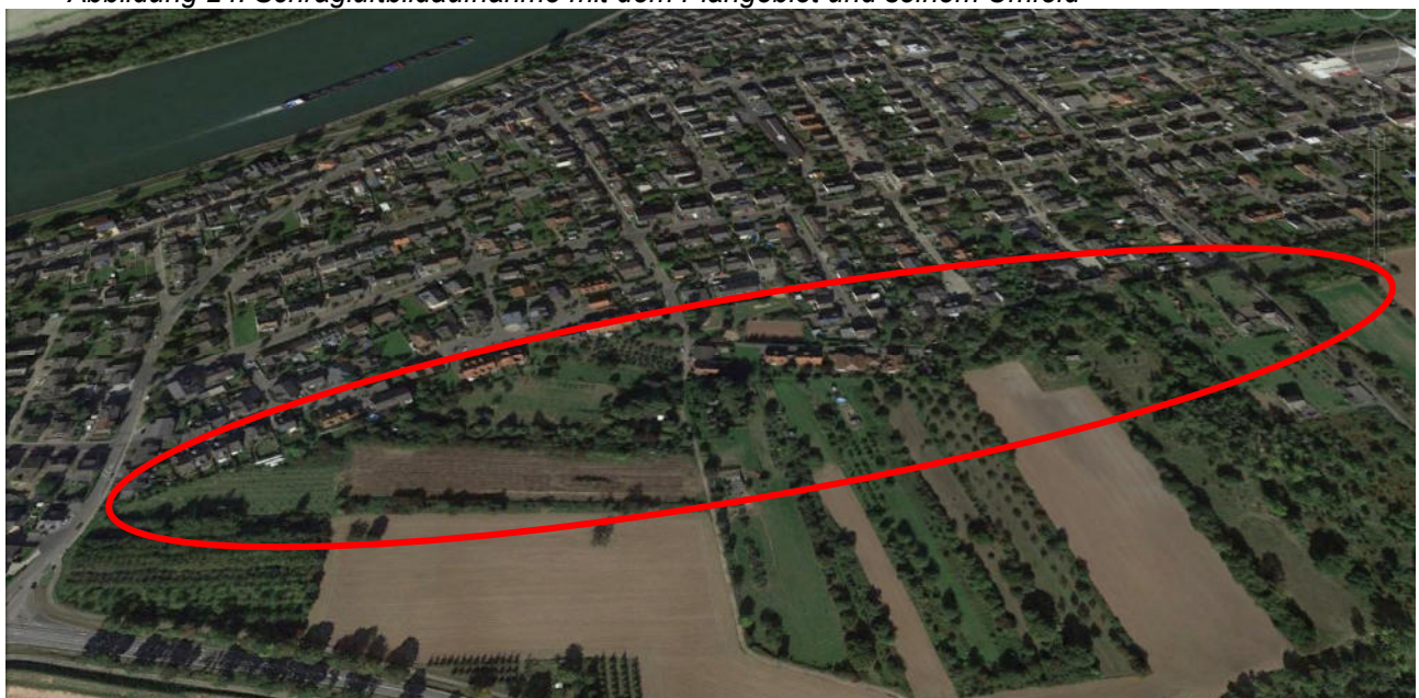
Abbildung 24: Schrägluftbildaufnahme mit dem Plangebiet und seinem Umfeld
