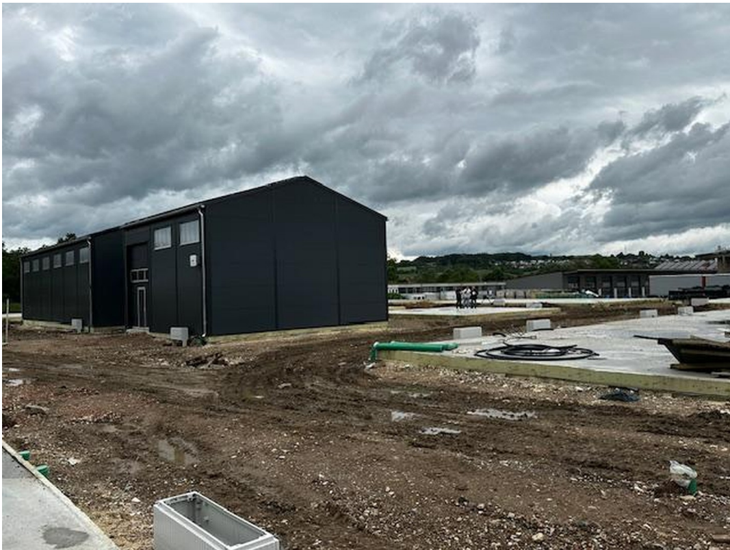
Straße derzeit im Bau
