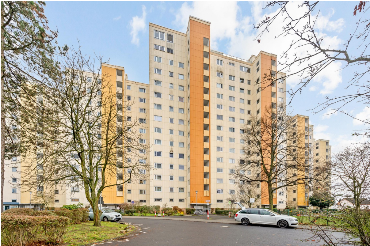
Gebäude vom außen
