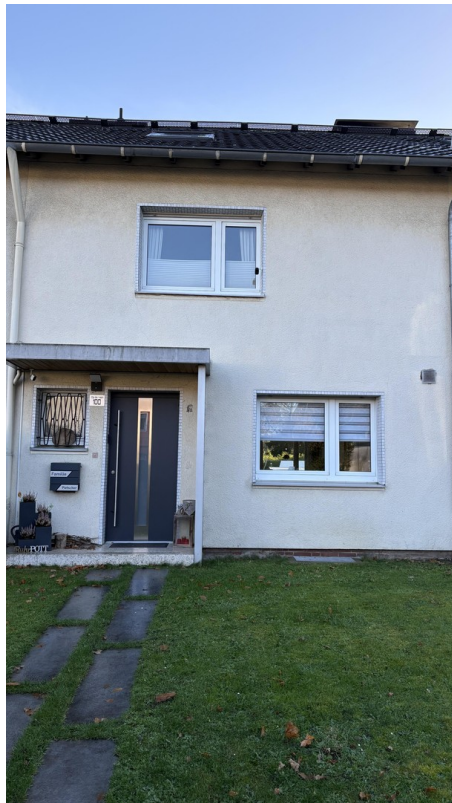
Hausansicht zur ruhigen Straße
