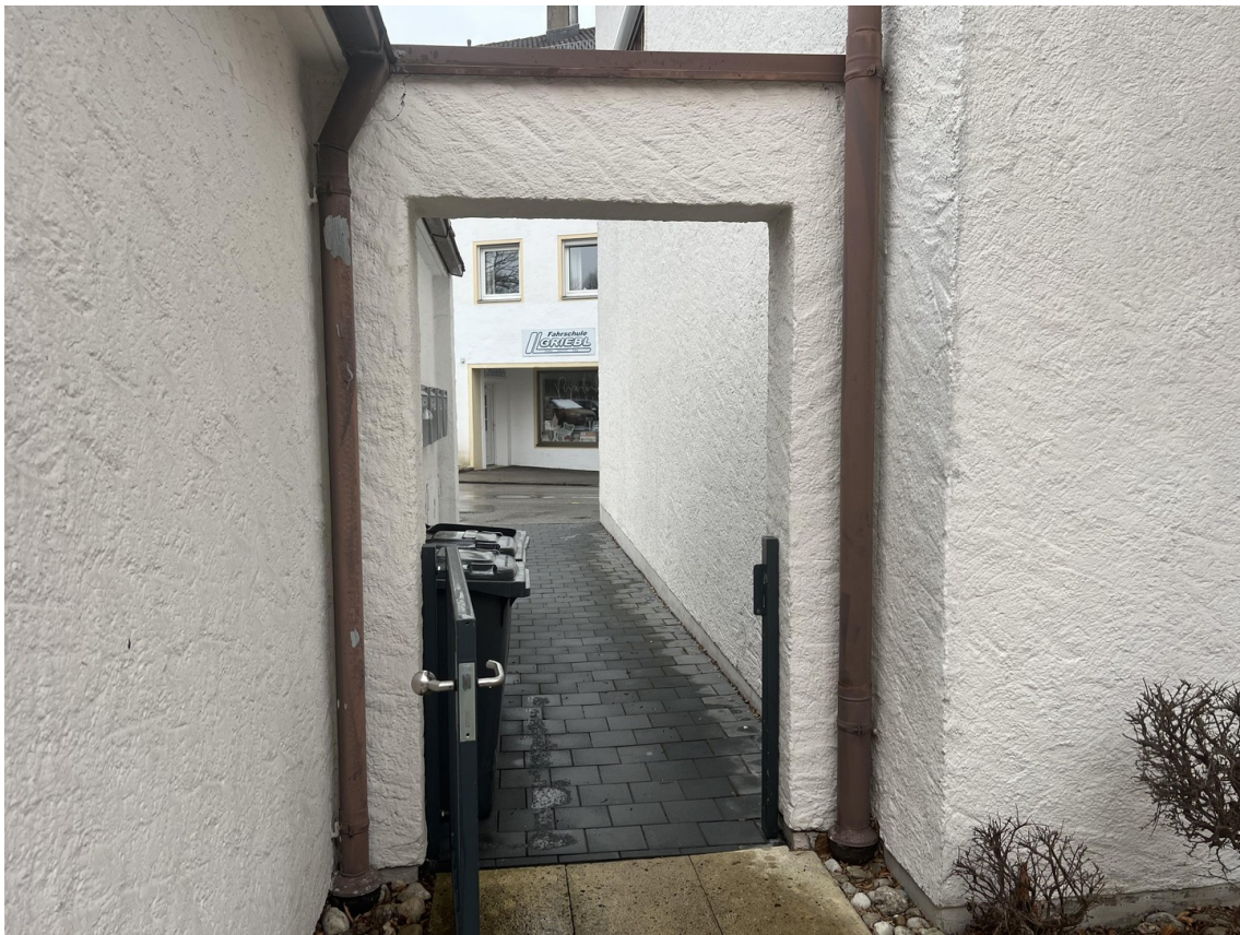
Zugang zum Haus
