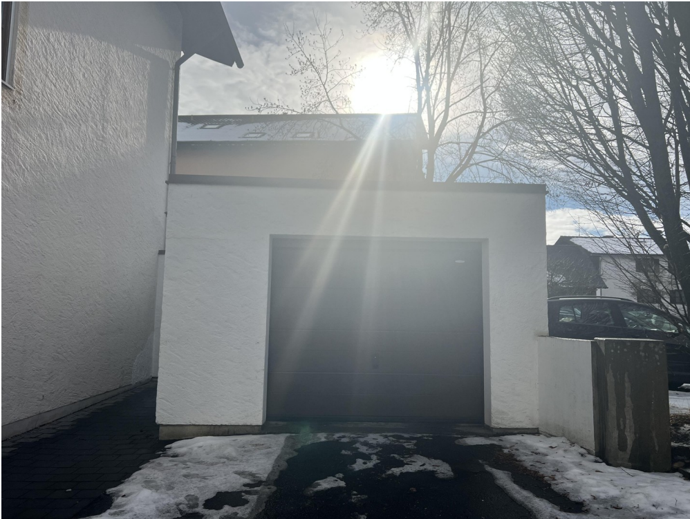
eigene Garage mit elektr. Tor
