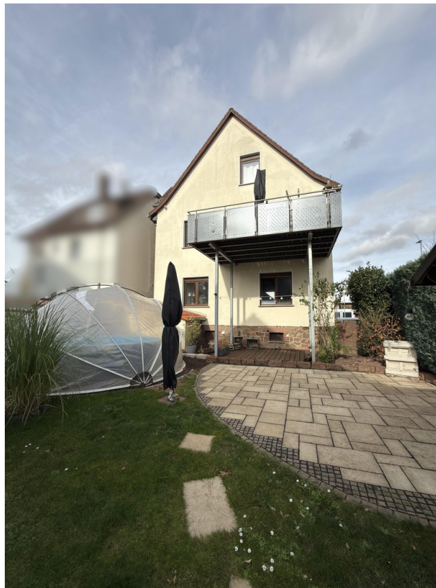
Gartenansicht mit Balkon
