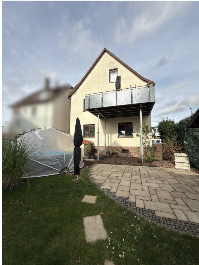
Gartenansicht mit Balkon
