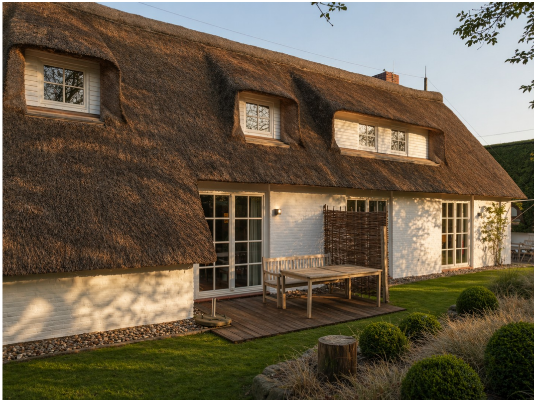
Ansicht Rückfassade App. M
