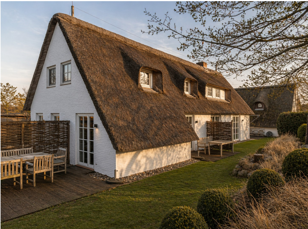
Ansicht Rückfassade App. S
