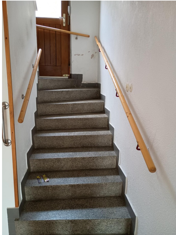
Treppe EG ins OG
