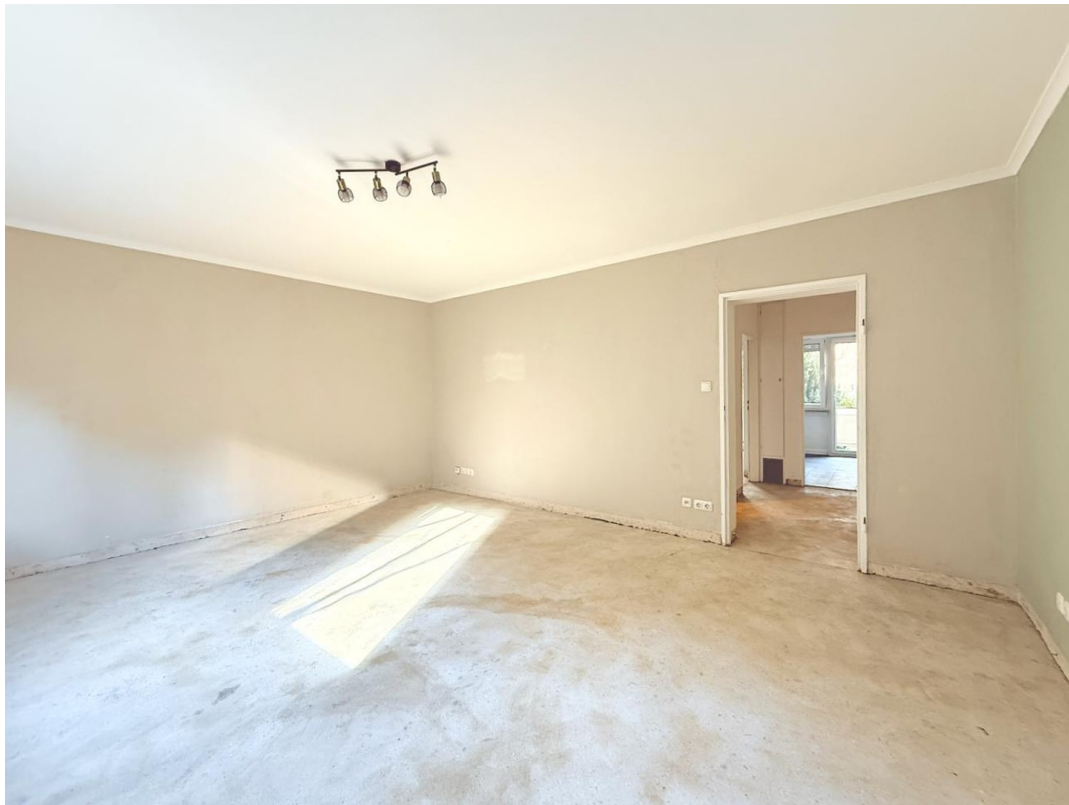
Wohnzimmer Flur Küche
