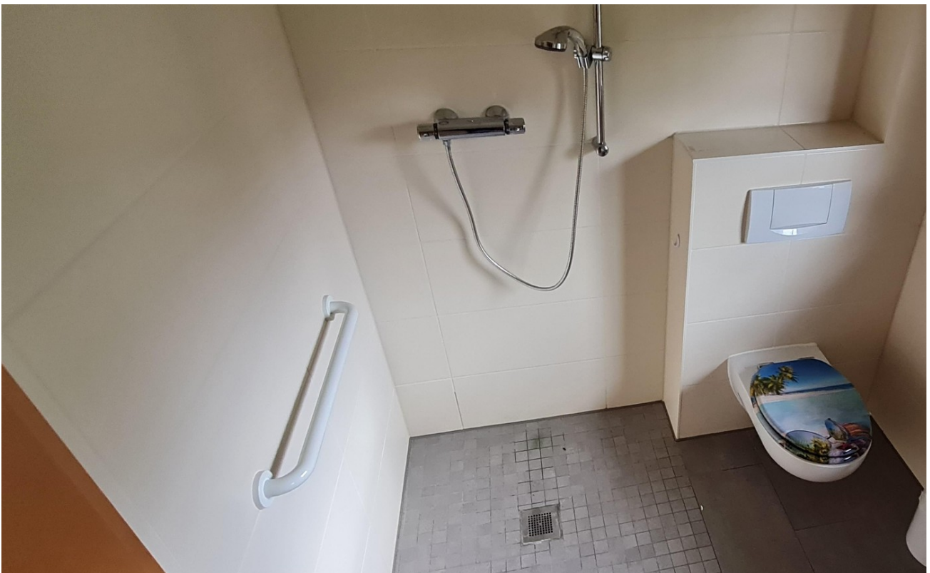
Barrierefreies Bad/Dusche EG
