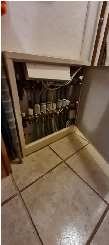
Stellmotoren Fussbodenheizung
