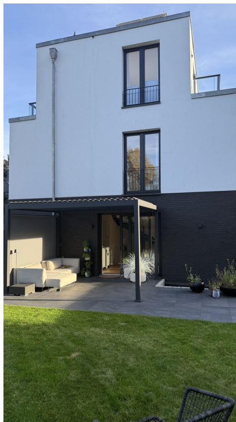
Hausansicht mit Terrasse
