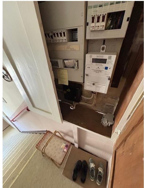
EG Treppenflur Elektrokasten
