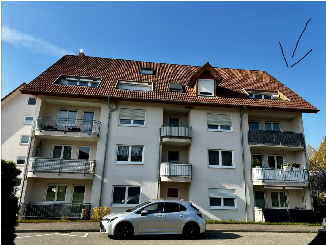
Hausansicht von der Straße
