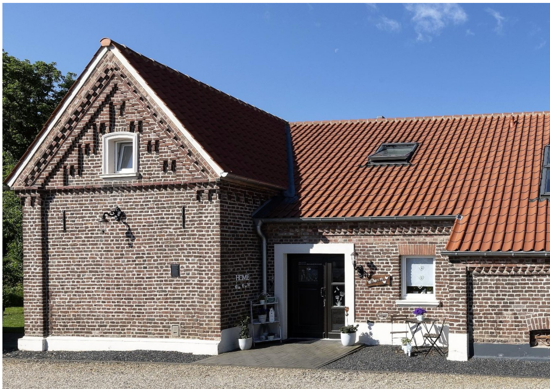
Blick auf den Eingang
