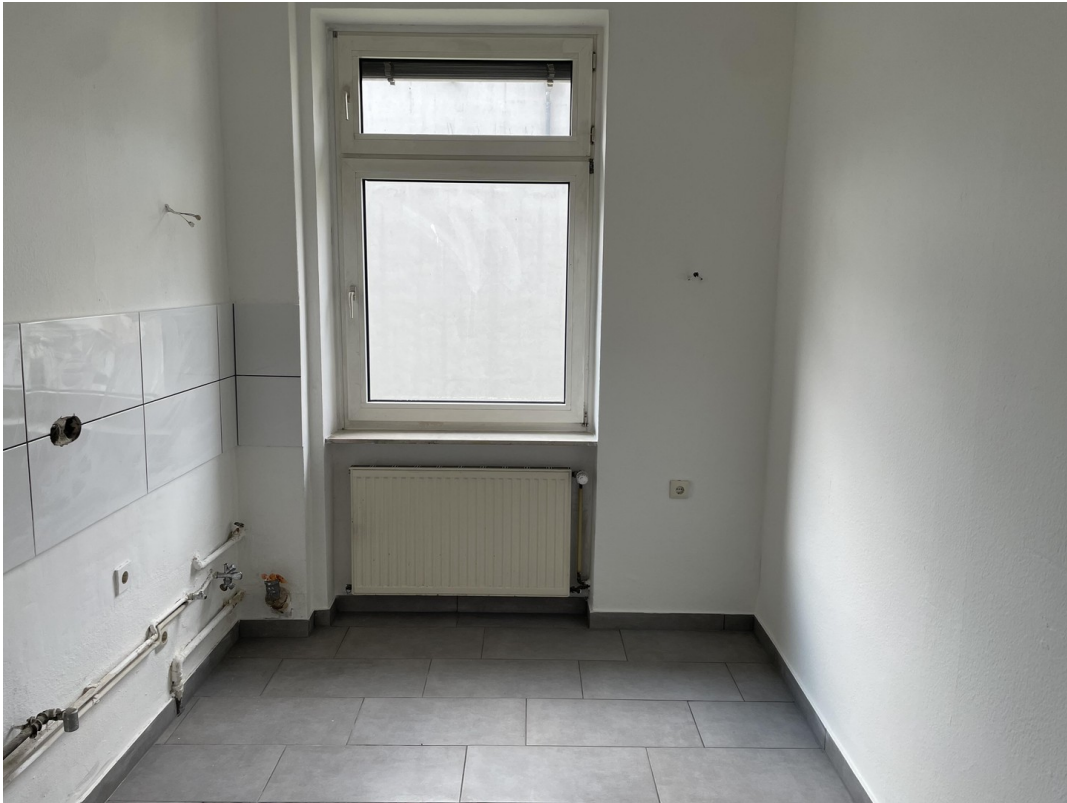
Küche mit neuen Fliesen (leer)
