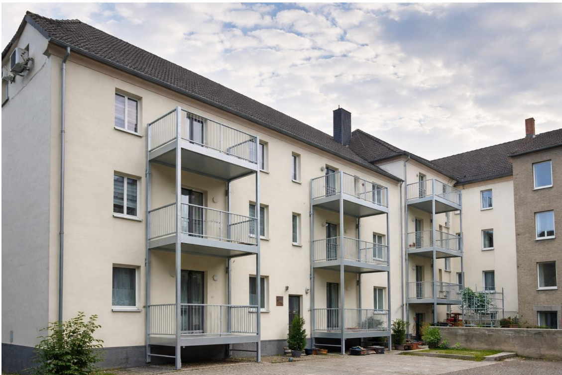
Balkone und Fassade
