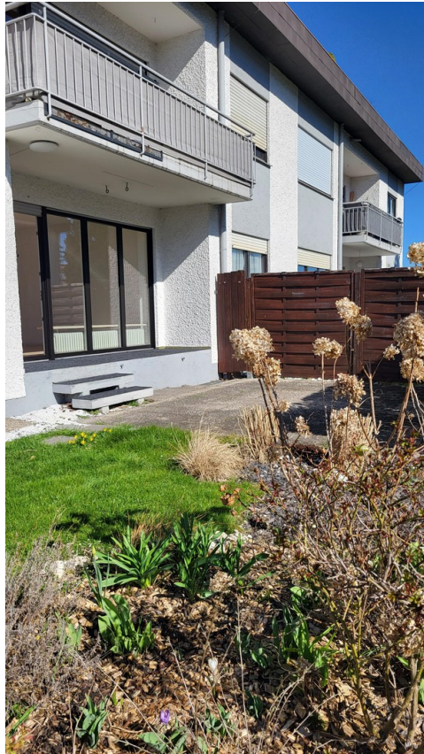
Loggia mit Südterrasse
