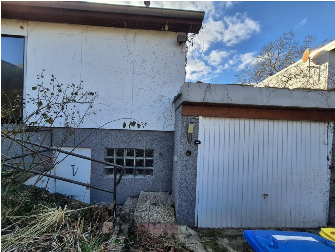
Außentreppe Keller & Garage
