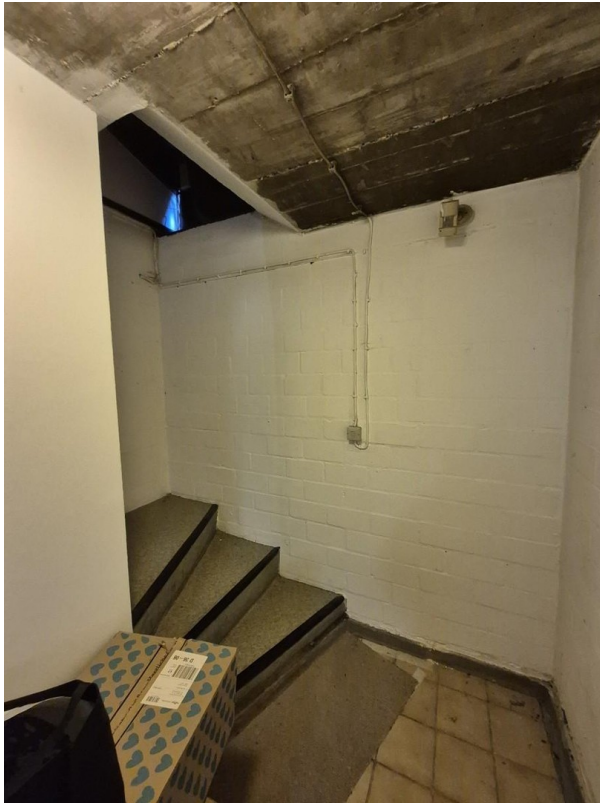
Treppe zum Kellergeschoss
