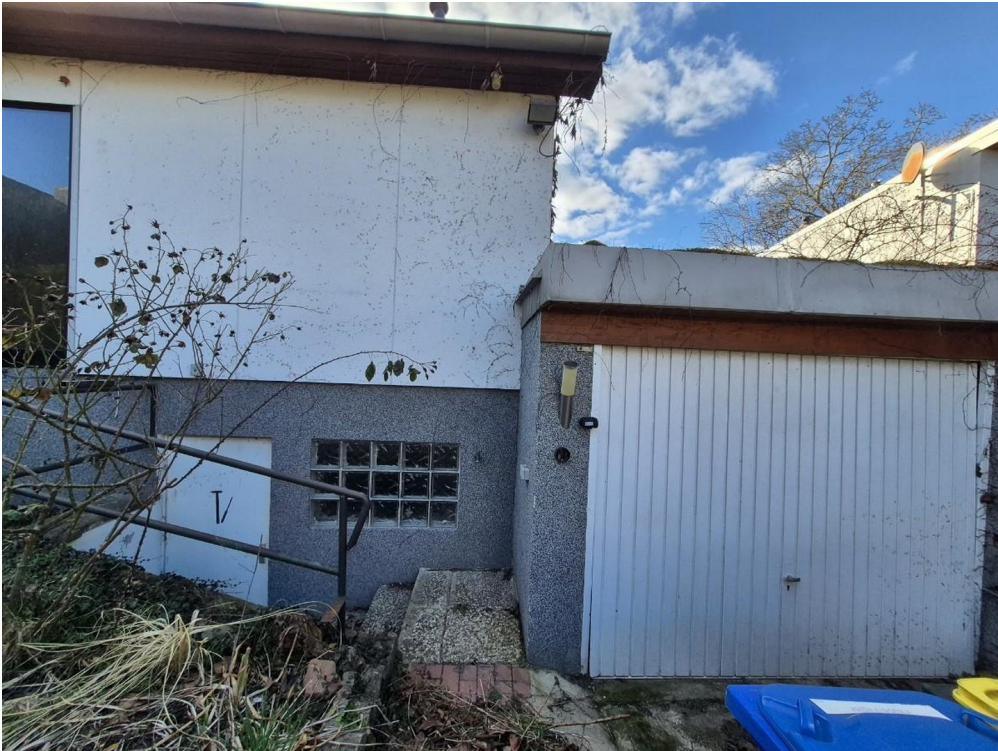
Außentreppe Keller & Garage
