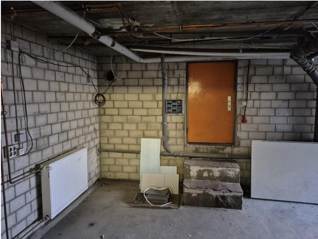
4.Keller:Zugang zur Garage
