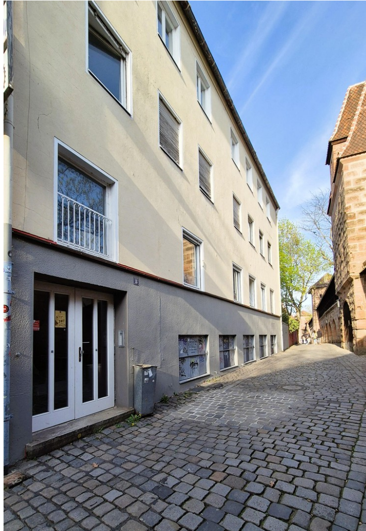
Hausansicht mit Stadtmauer
