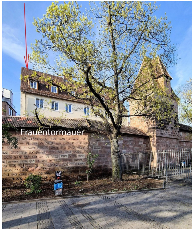
Blick auf das Gebäude
