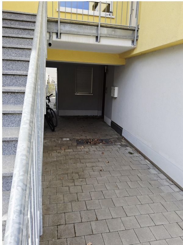
Eingang überdacht unten rechts
