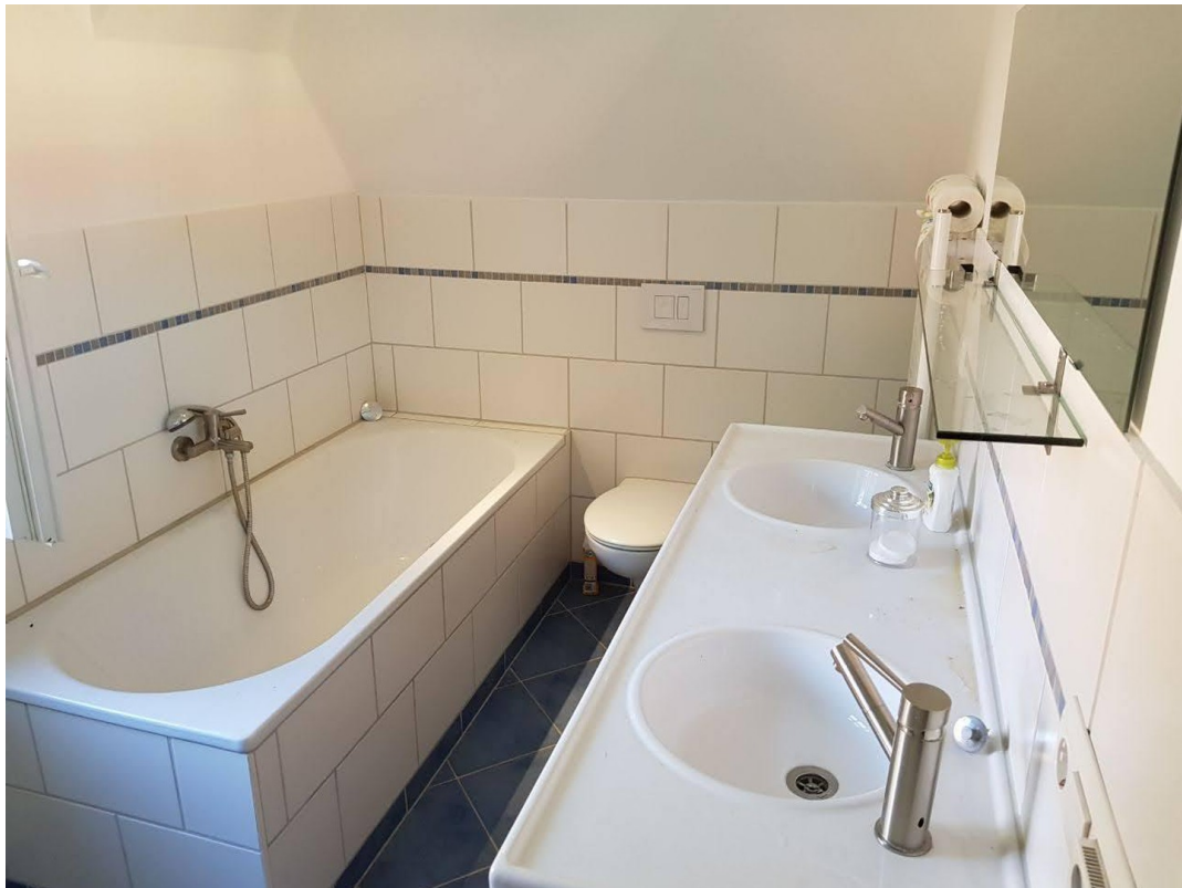
Badezimmer im 1. OG
