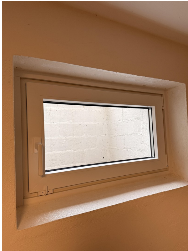
neue Kellerfenster seit 2025
