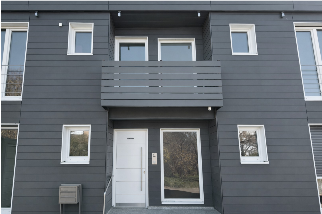
Eingangsbereich mit Nordbalkon
