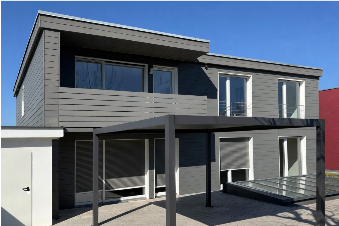
Blick auf die Südfassade
