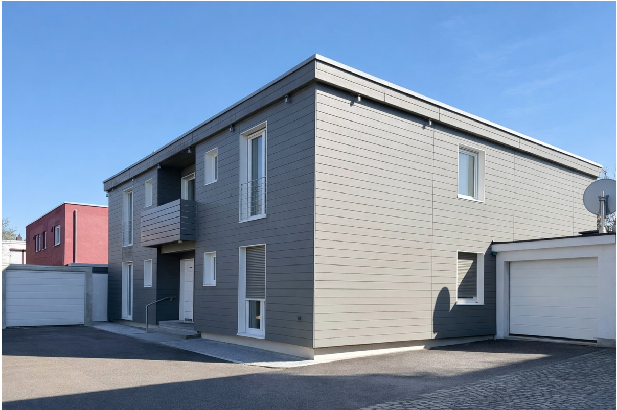
Zufahrt mit den Garagen
