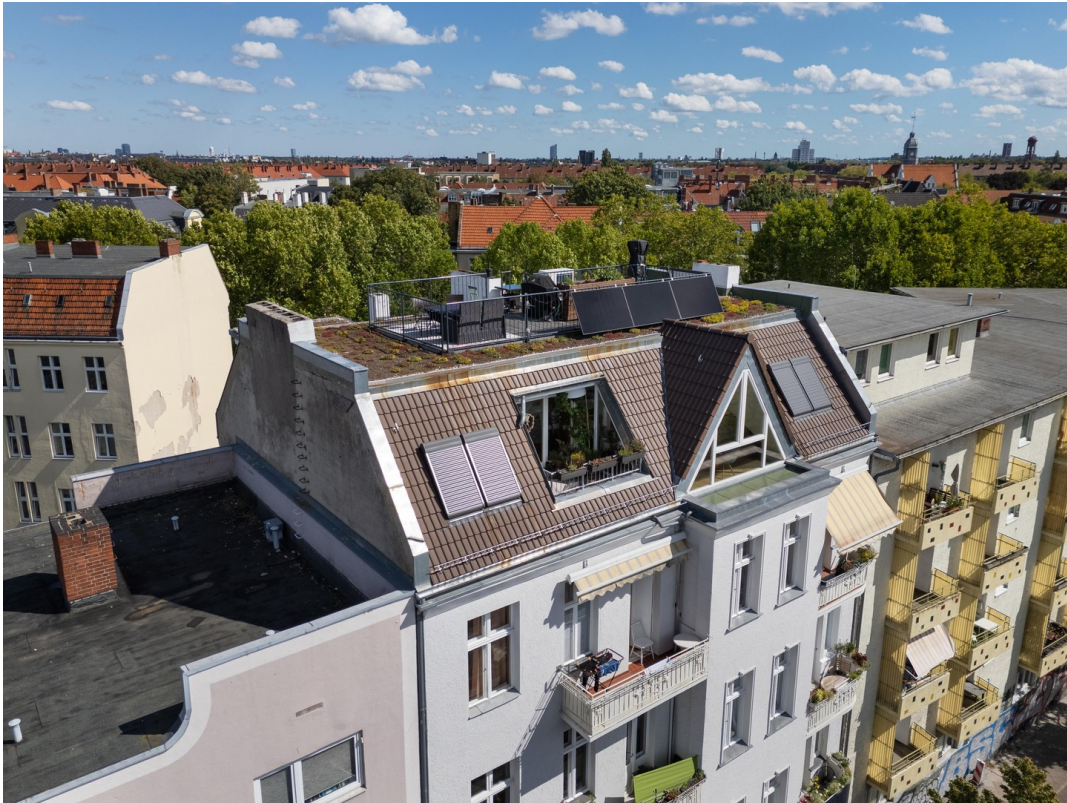
Neue DG Ausgebaut
