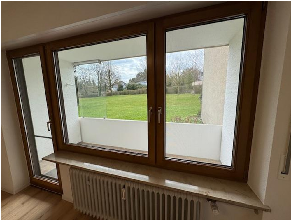
Blick auf Balkon
