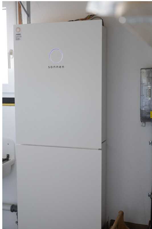
Batteriespeicher (erweiterbar)
