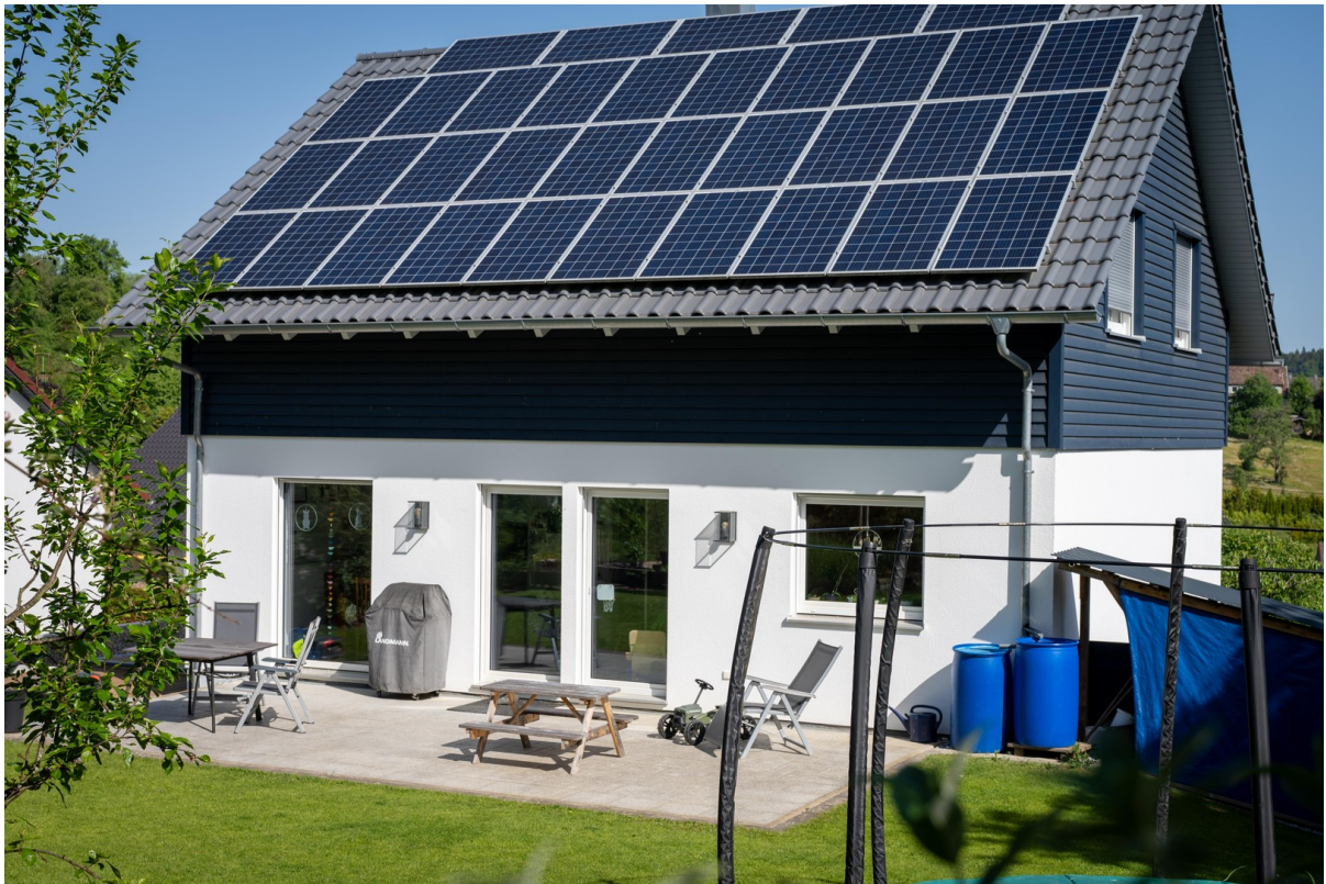
Südseite mit PV-Anlage
