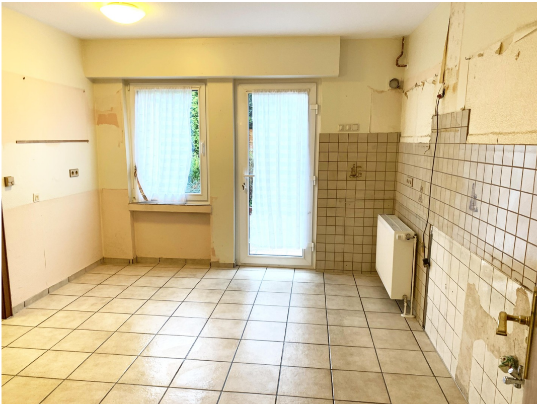
Küche (vor Renovierung)
