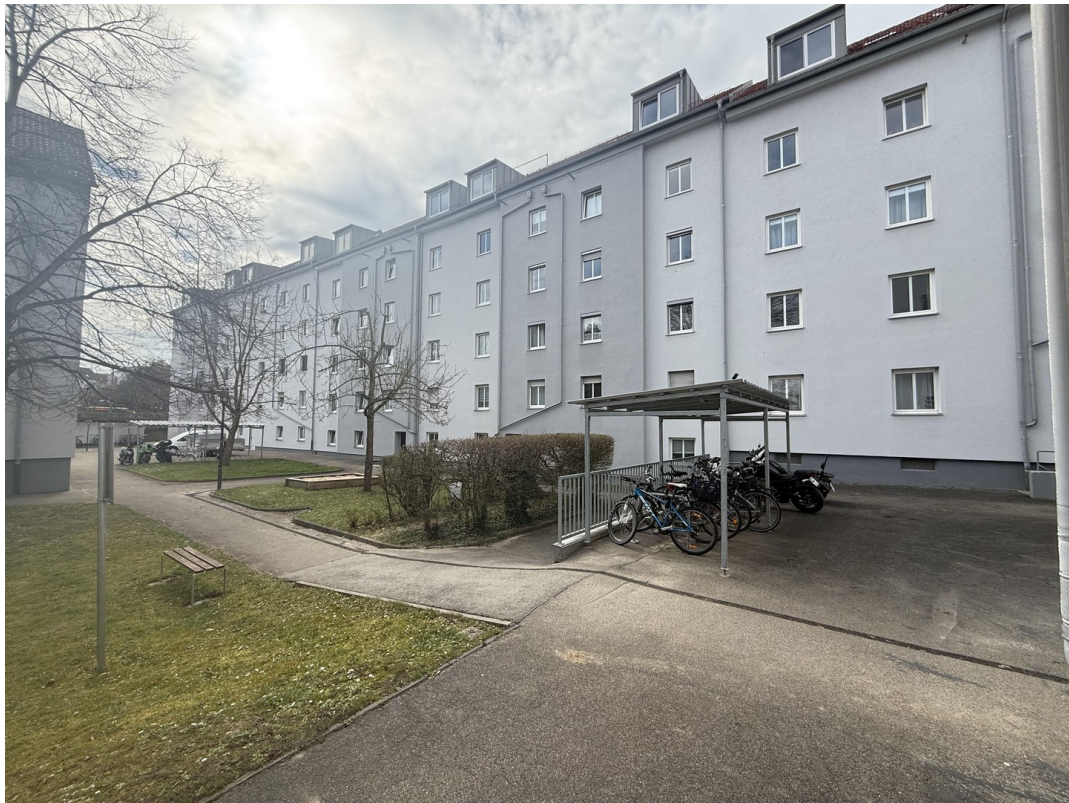
Außenansicht von Innenhof
