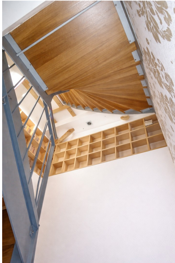
innenliegende Treppe 3./4. OG
