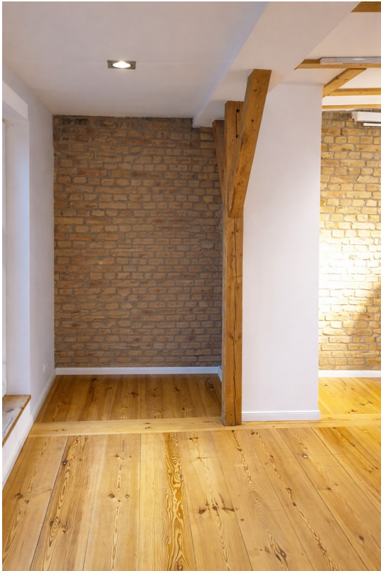
Erker mit Mauerwerk und Balken
