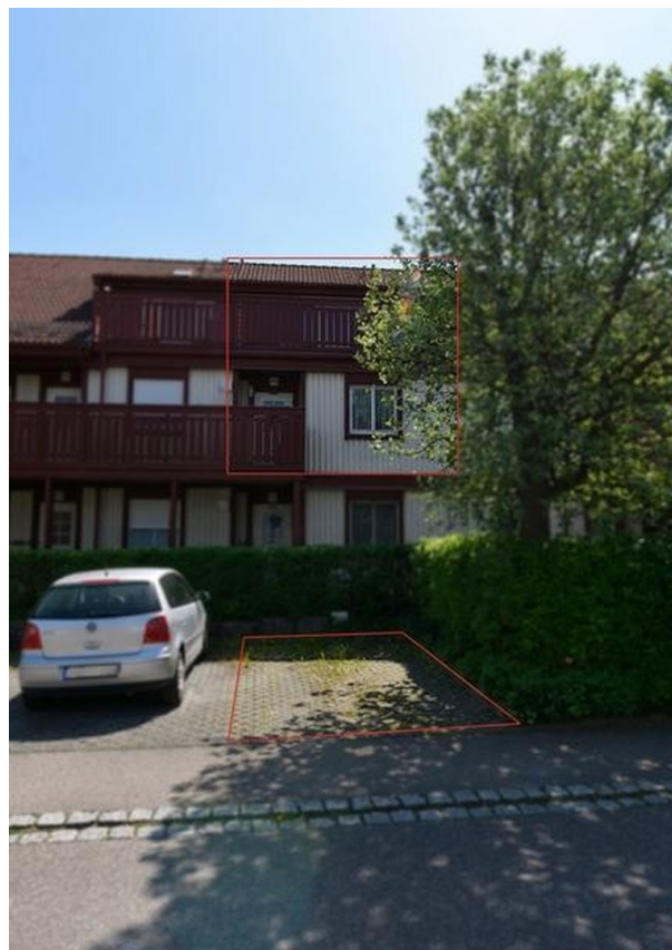
Außenseite Nord mit Stellplatz
