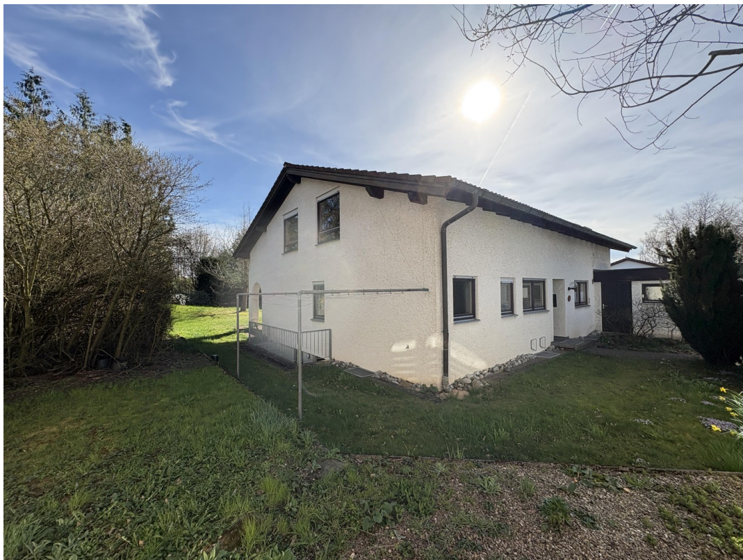
Ansicht aus Nordost
