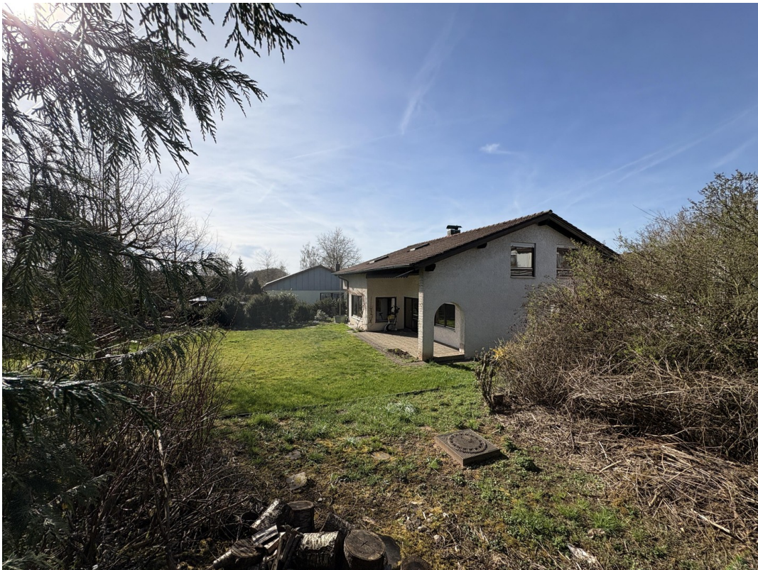
Ansicht aus Südosten
