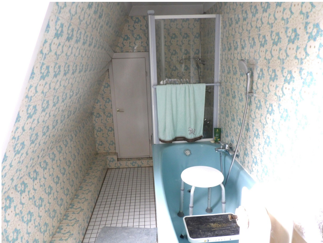
Duschecke Bad OG
