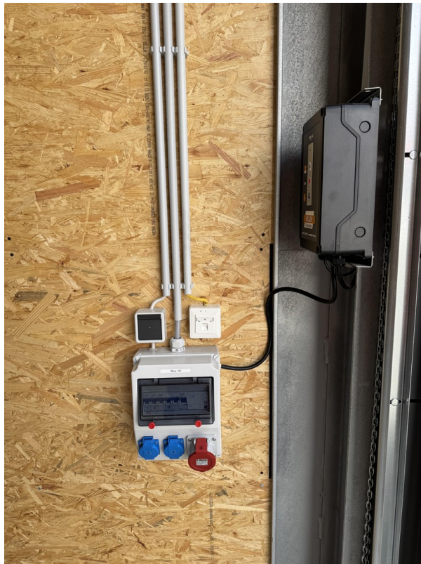
Elektrische Unterverteilung
