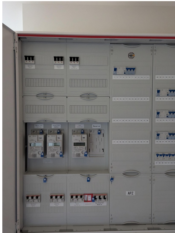
neuer Stromverteilerkasten
