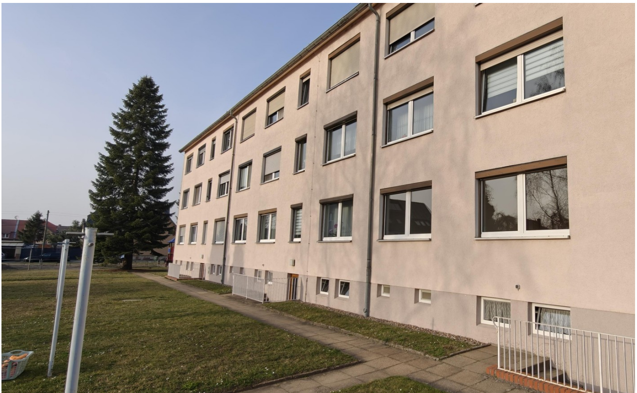
Rückseite des Gebäudes
