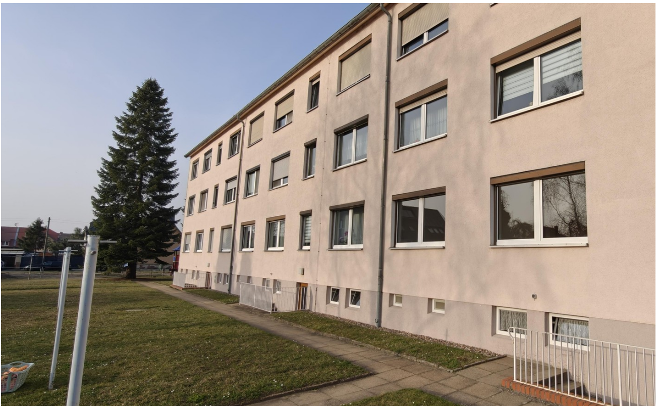
Rückseite des Gebäudes
