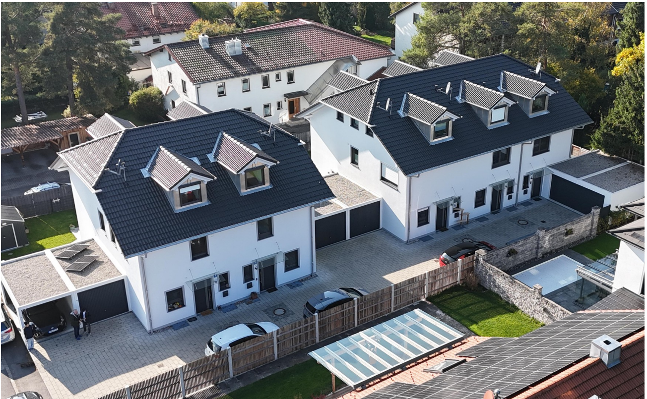
Hauszugang und Zufahrt
