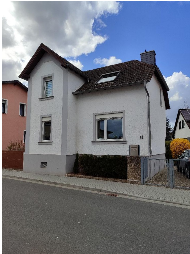
Blick von der Straße
