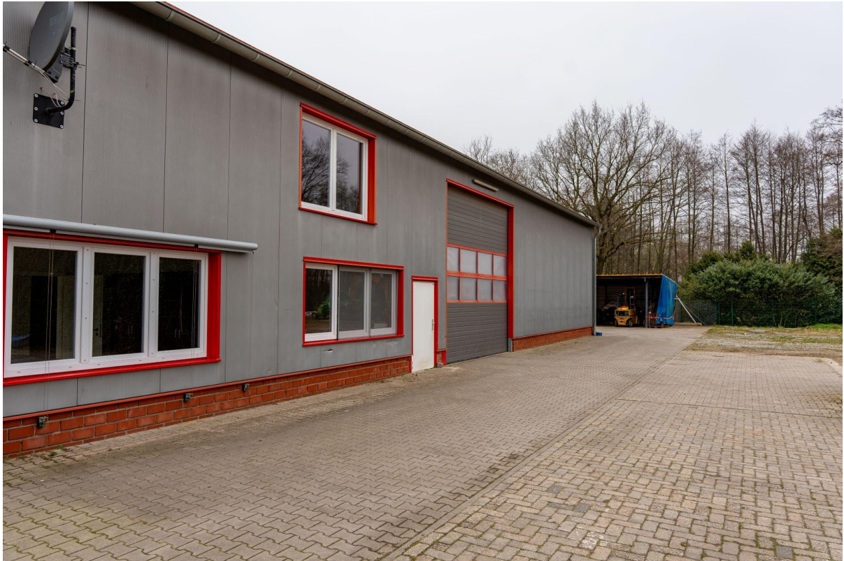
Zufahrt zur Halle- Tor 1
