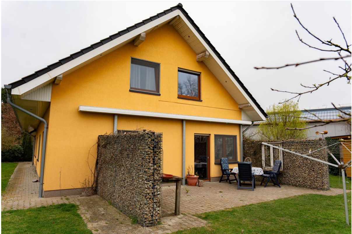
Terrasse an der Küche
