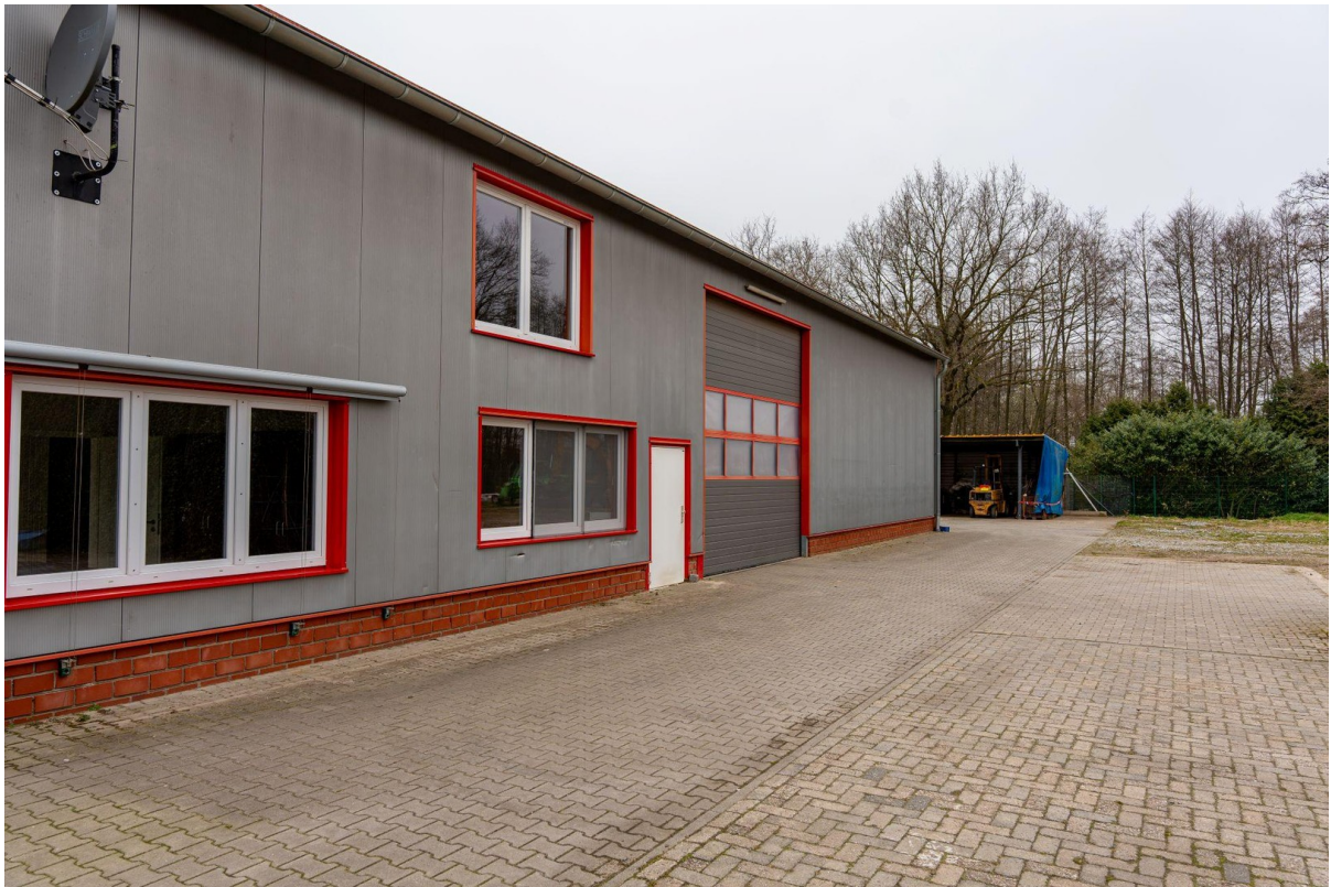
Zufahrt zur Halle- Tor 1
